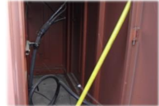
高圧ケーブル
